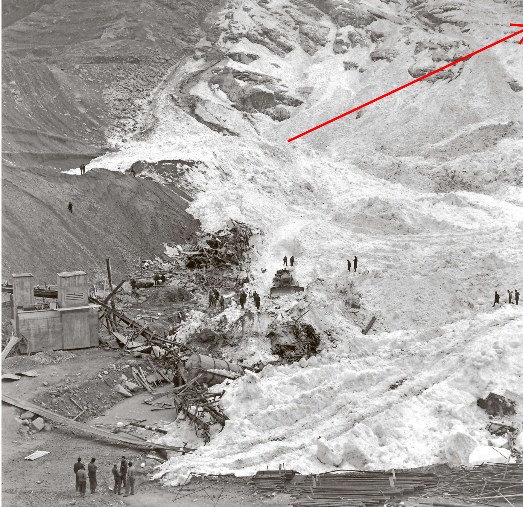
30.8.1965: Katastrophe beim Staudamm-Bau. Am 30. August 1965, um 17.15 Uhr, brach die Zunge des Allalingletschers ab. Rund zwei Millionen Kubikmeter Eis und Geröll krachten 600 Meter in die Tiefe und verschütteten die Wohn- und Arbeitsbaracken, in welchen die Bauarbeiter lebten, die den Mattmark-Stausee im Saastal bauten, auf Boden der Gemeinde Saas-Almagell. Die Bewohner hatten keine Chance, denn die Baracken, die Werkstätten und die Kantine lagen in der direkten Falllinie unter dem Gletscher. Die traurige Bilanz: 88 Tote, darunter zwei Frauen, und fünf Verletzte. Die Todesopfer stammten aus Italien (56), der Schweiz (23) und Spanien (4) sowie weiteren Nationen (5). Die Katastrophe hatte sich angekündigt: In den Tagen vor dem Unglück fielen immer wieder Eisklötze zu Tal. Nur noch acht Meter Höhe fehlten am Staudamm, man konnte oder wollte sich einen Unterbruch nicht leisten, weil die Zeit drängte. Sieben Jahre später kam es zum Prozess vor einem Gericht in Visp. Nach einer Woche Verhandlung wurden alle 17 Angeklagten, darunter Ingenieure und Direktoren einer Elektro-Gesellschaft, freigesprochen. Foto Keystone
